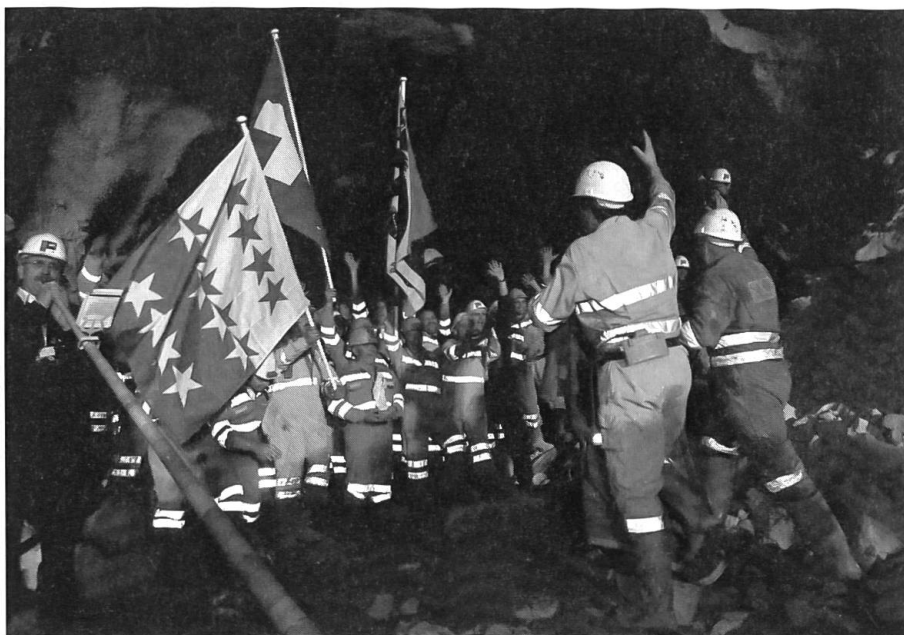
Zusammentreffen der Arbeiter nach dem Durchbruch im Lötschberg (Foto: Keystone)
