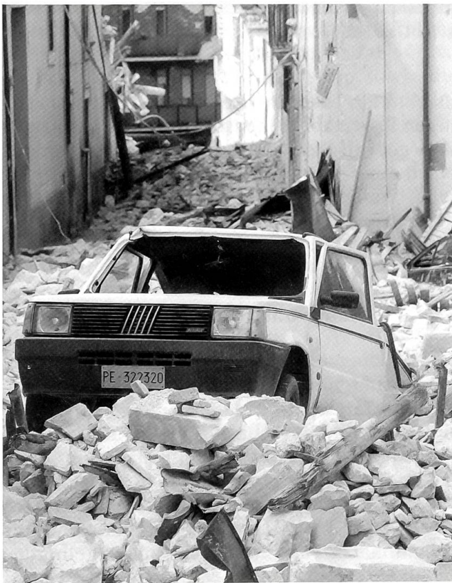
Bild nach dem verheerenden Erdbeben in den Abruzzen (Foto: Keystone)
