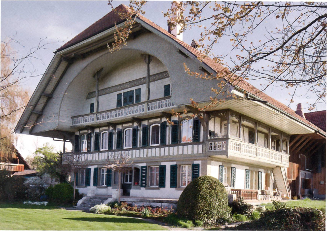
Iffwil, Dorf 5, Bauernhaus von 1911, Gesamtaufnahme. Foto 2012
