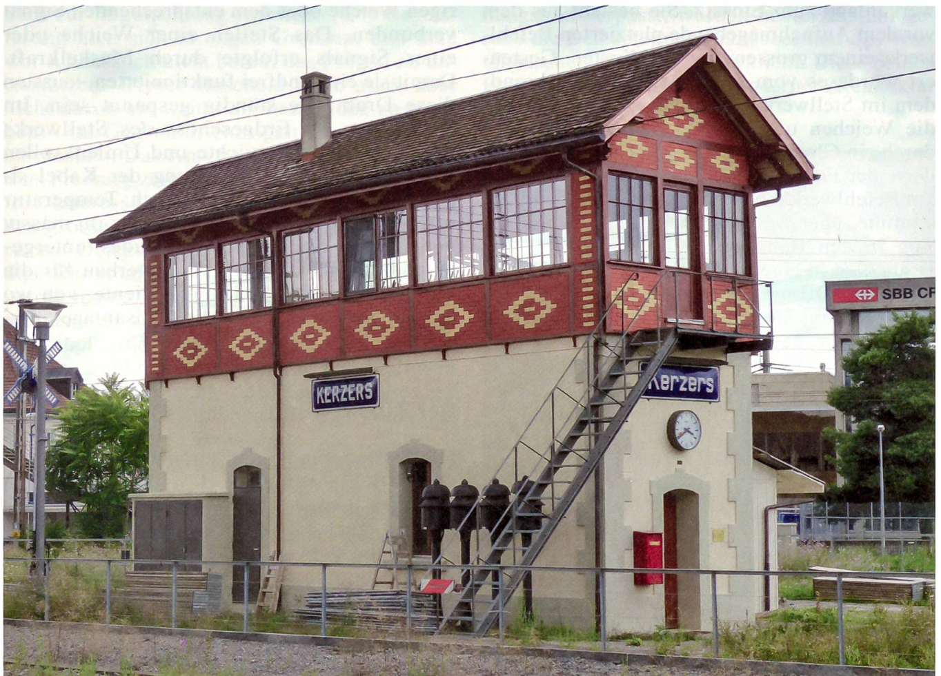
Das 1901 erbaute Stellwerkgebäude
