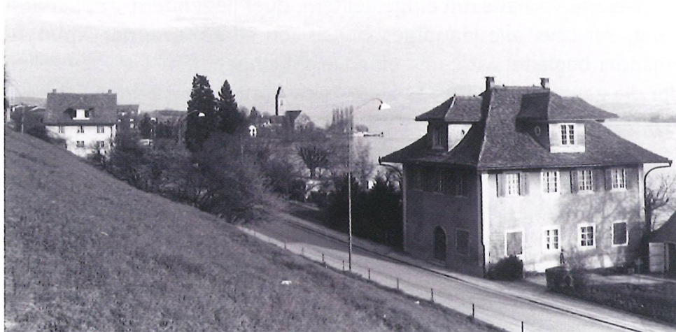
Seehalde und Pächterhaus (Zustand 1975).
