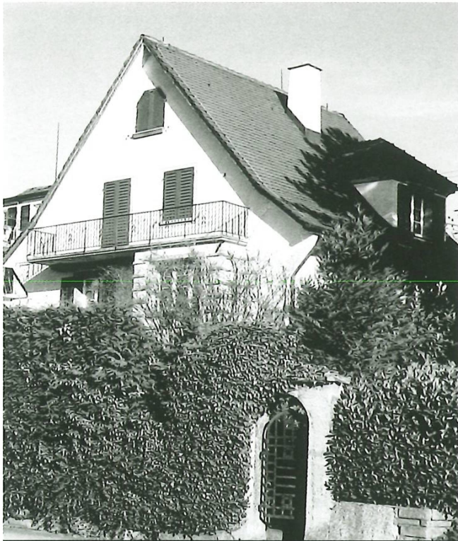
Seestrasse 15, von Südosten.
