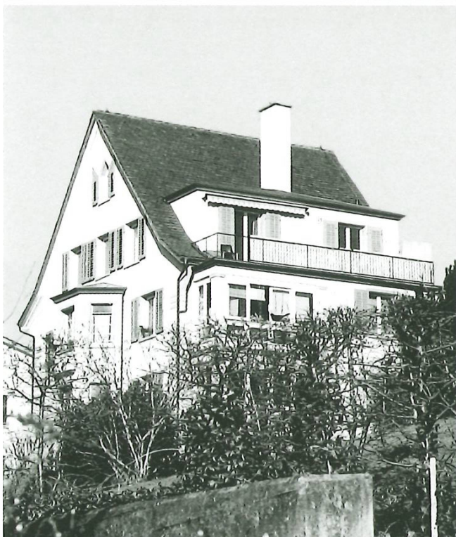
Teienstrasse 98, von Südosten, zum Abbruch vorgesehen.
