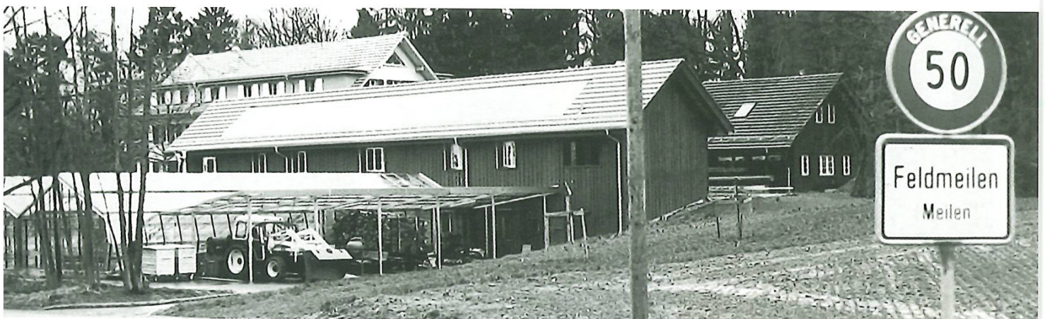
Gärtnerei mit Glastreibhäusern vor dem Umbau.
