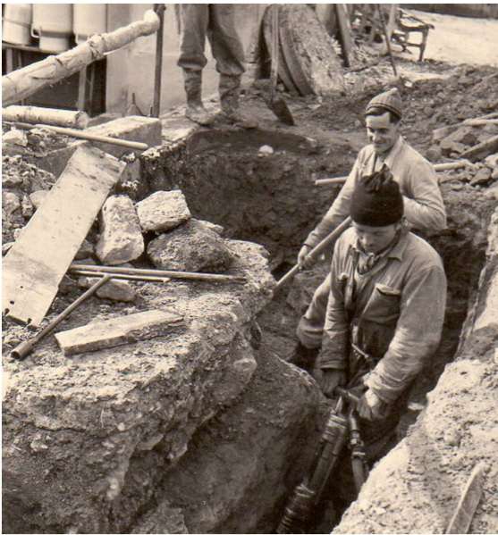
Jakob Dolder (hinten) beim Bau einer Wasserleitung, einer Aufgabe, die früher noch die Genossenschaft der Burg-Bauern wahrnahm.
