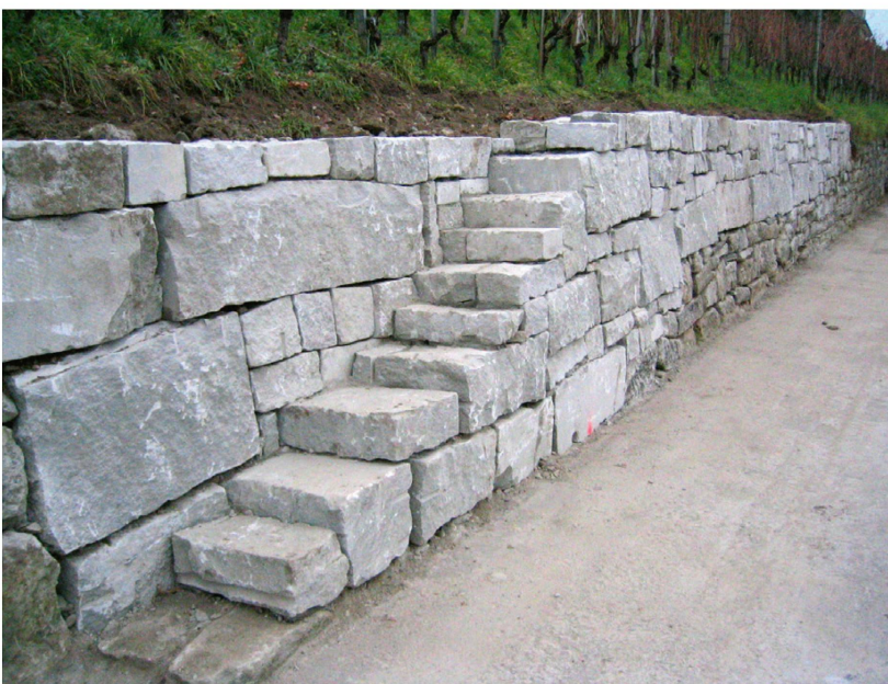
Auch diese Trockensteinmauer an der Alten Landstrasse wurde vom Naturschutzverein gebaut.
