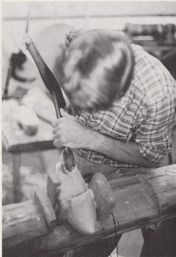
L'herminette et le couteau nommé départoir voisinent avec le sabot en voie de fabrication.
