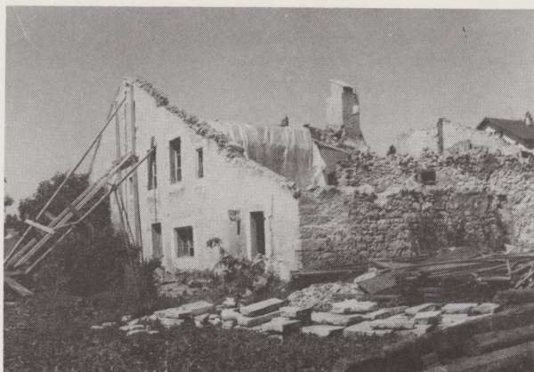
Sans l'ancienne charpente, début août 1980.
