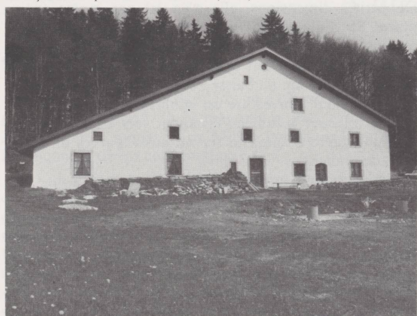
La façade sud après la rénovation. – (1981)
