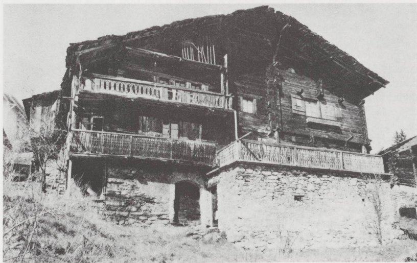
Galerie au-dessus du soubassement à Arbaz (Valais).
