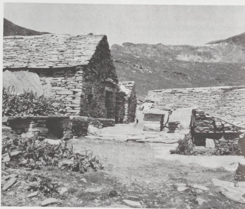
Bâtiments en pierres sèches érigés dans les alpages du Tessin.
