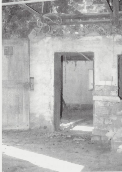
Ci-contre, la cuisine voûtée. Dans l'étaufoir, un assemblage de perches, encore visible aujourd'hui, qui servait à fumer la viande.
