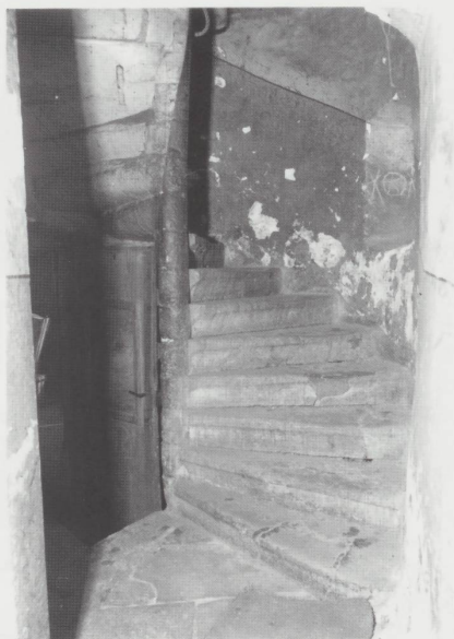
L'escalier à vis dans la tour.
