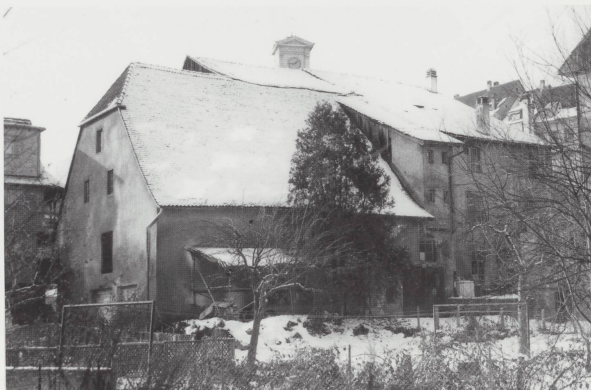
Façade est du bâtiment.
