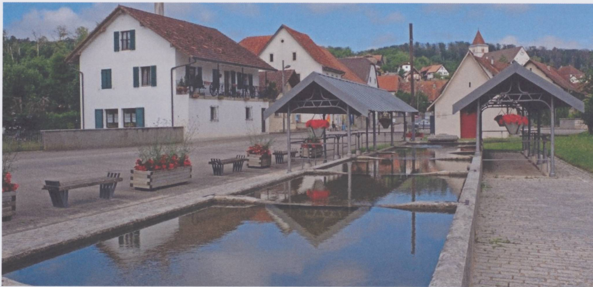
Figure 3 : Coeuve, Lavoir public alimenté par la source de la Coeuvatte. Installé au milieu du XVIII e siècle et transformé en 1894. Les bassins de lavage en pierre sont en partie abrités par des toits de tôle soutenus par des supports en fonte. Classé monument historique en 1973, il a été entièrement rénové en 1999. (Photo Jean-louis Merçay, 2021)
