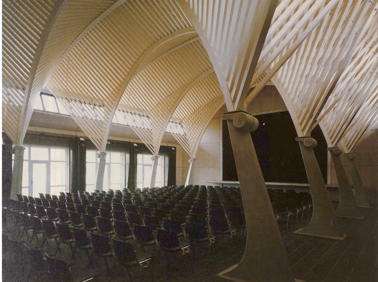
Kein Deckel, sondern eine Decke. Fünf Stabwellen stützen eine Tonne.
