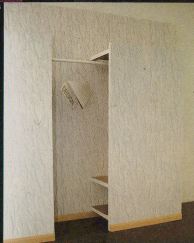
Variationen zum Wandschrank mit variablen, frei zugänglichen Regal-Einteilungen. Wand und Schrankoberflächen sind mit derselben Tapete bezogen.
