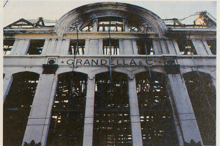
Das ausgebrannte Warenhaus Grandella (links und oben) im Lissaboner Altstadtviertel Chiado ist Teil der Unterstadt aus dem 18. Jahrhundert und zum «Kulturgut von nationalem Interesse» erklärt.
