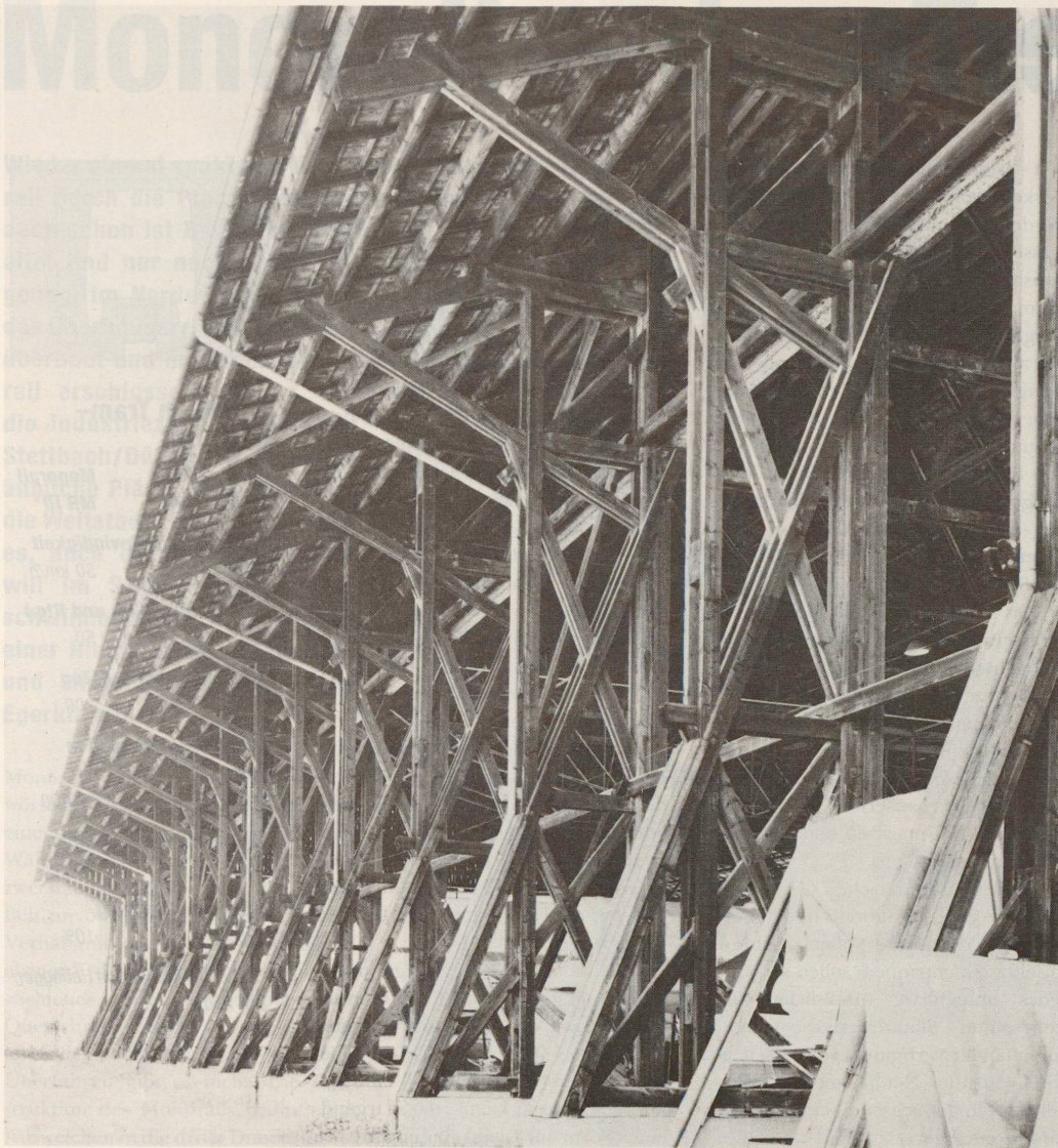
Eine reife Bauingenieurleistung von hoher Qualität: Die Bretterhalle von Lachen, längsseitiger Blick auf die Konstruktion.
