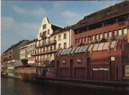
Früher Büchsenfabrik, heute Begegnungszentrum (oben); die neu-alte «alte Oele» in der Altstadt (Mitte); das Geschäftsquartier Bälliz von der Aare her (unten)
