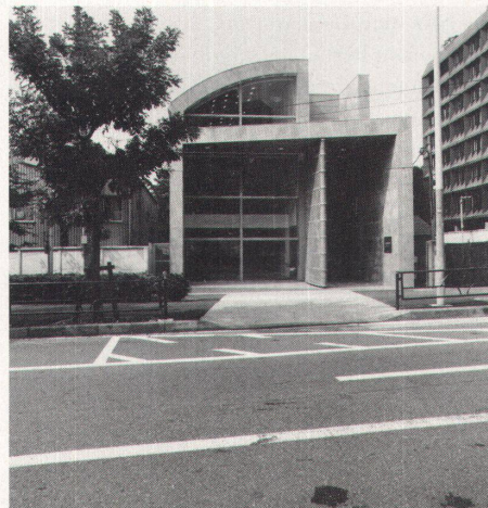
Das Ladengebäude der Obayashi Corporation in Tokio von aussen und ein Blick in die Büros
