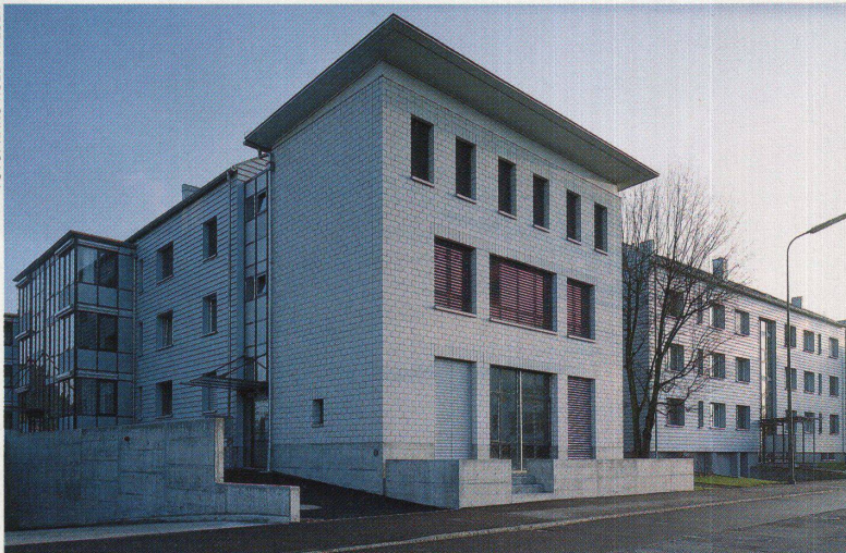
Aarepark Solothurn: ein Demonstrationsobjekt
