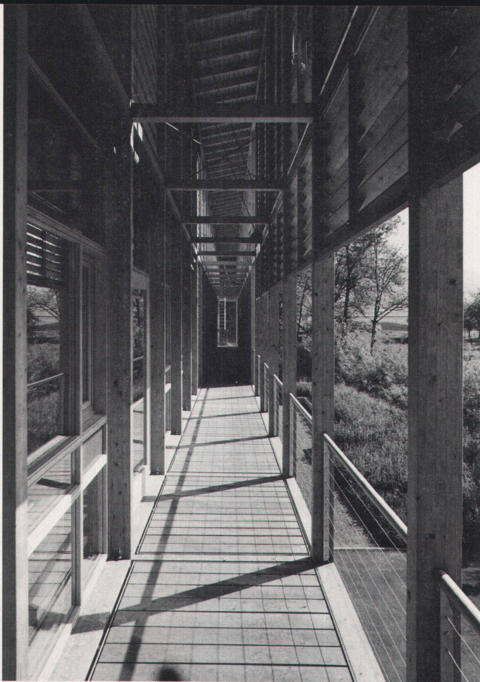
Blick in die Raumhülle zwischen Fassade und Bretterwand: Holzkonstruktion mit Raffinesse (links oben)
