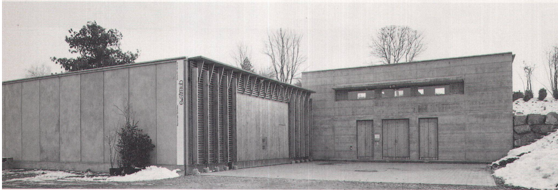
Blick von der Zugangsstrasse auf die Werkgebäude der Baumschule Straub in Freidorf TG. Links die Einstellhalle, rechts der Büro- und Werkstatttrakt
