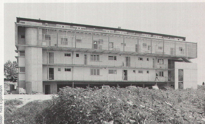
Die Nordfassade: Die verglaste Laube vor den Maisonnettewohnungen ist auch ein gedeckter Spielplatz
