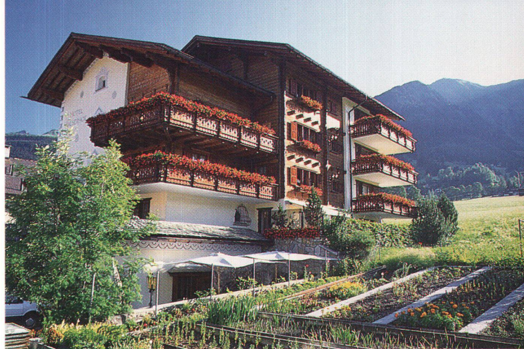
Das allgemein Alpenländische: massiver Sockel, Fassadenecke im Blockbau und Satteldach mit Ziegeln
