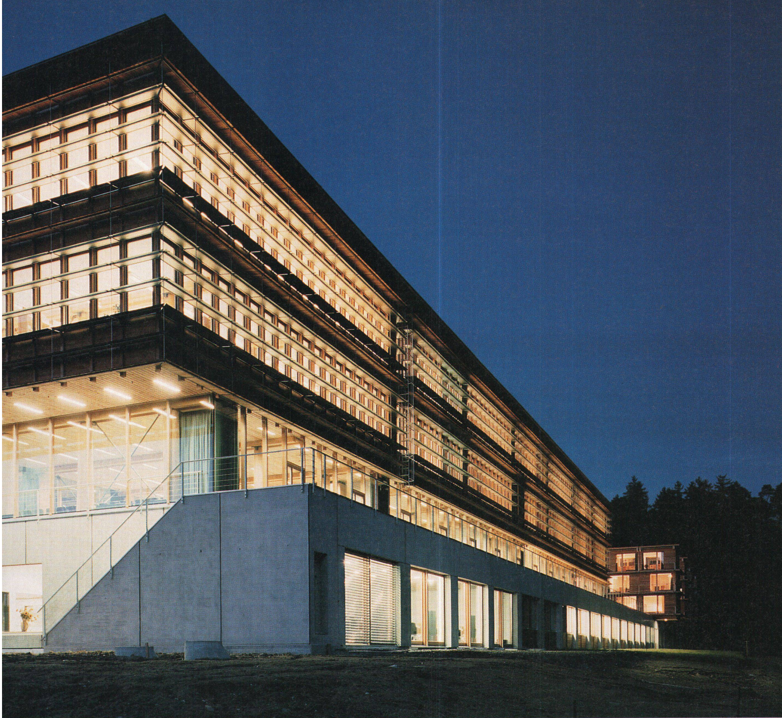
Die Försterschule nachts. Über dem alles zusammenfassenden Sockel erhebt sich vorne der Schultrakt. Im Hintergrund das Internat
