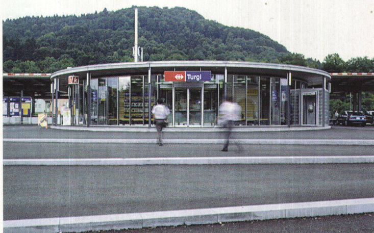
Turgi: Der Zylinder besteht aus einem Dach auf vier zentralen Pfeilern, das Vordach liegt auf sechzehn schmalen peripheren Stützen. Eine transparente Fassade trennt den Innen- vom Aussenraum.
