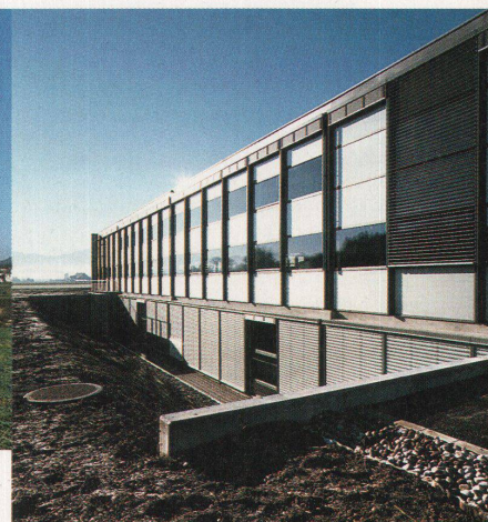
Ein Ensemble weiterbauen: USM in Münsingen hat zum sechsten Mal erweitert. Immer mit dem gleichen System. Ein Graben sorgt für Tageslicht im Untergeschoss (rechts)
