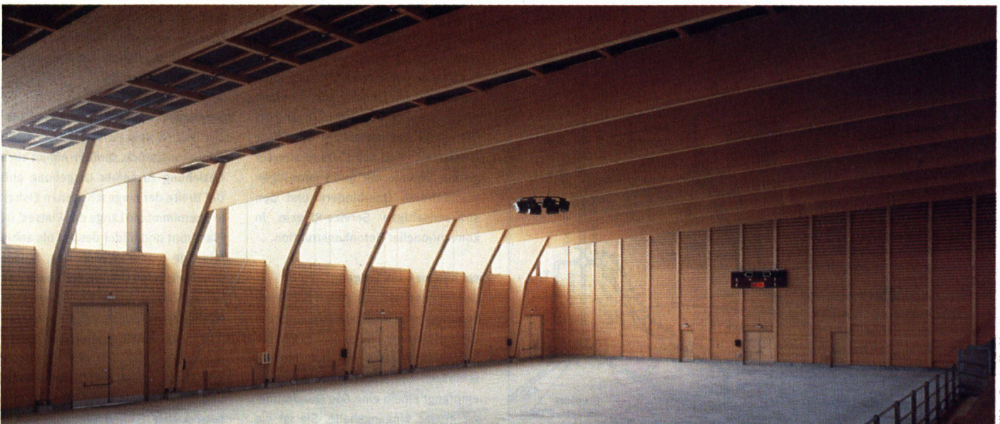
Die Eishalle mit ihren gewaltigen Querbindern erweitert die Ausstellungsfläche des Espace Gruyère von 6000 auf 8000 Quadratmeter
