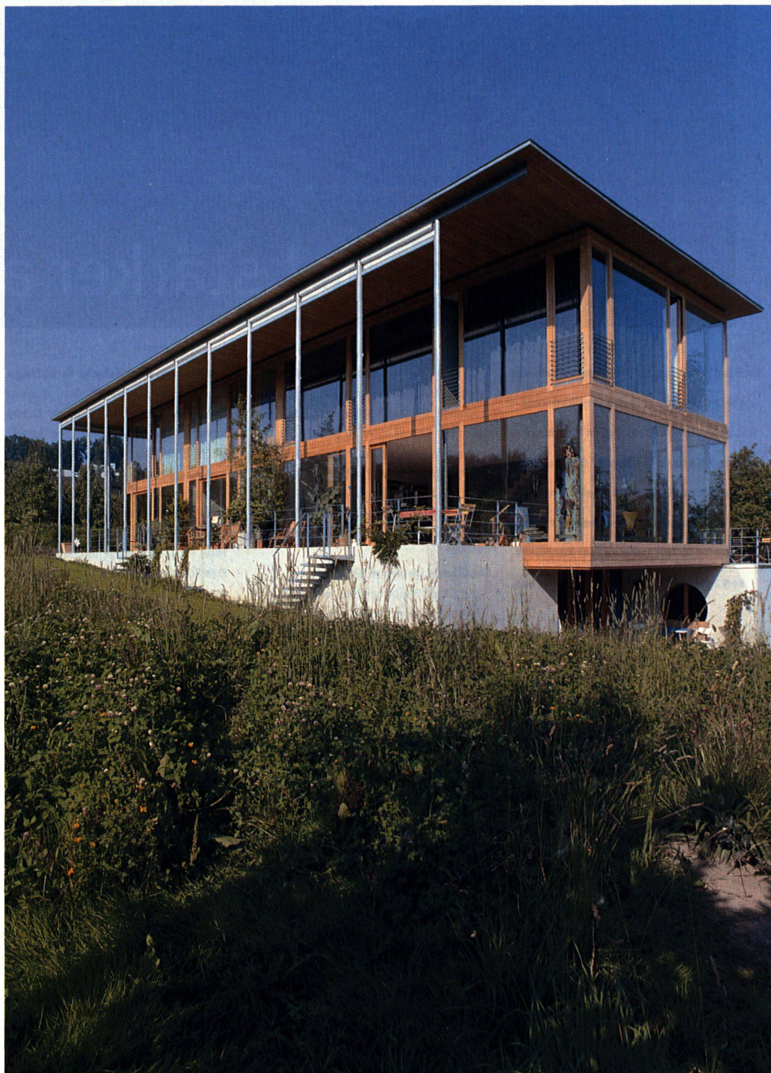
Die Glasfassade für Lichtdurchflutung. Der Sockel bleibt hinter dem Glaskörper zurück, dieser kraxt gegen den See
