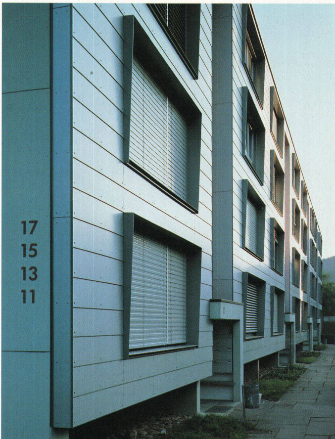
Stahlzargen schützen die Holz/Metall-Fenster auf der Eingangsseite. Indem sie die Form der Metallschwerter der Gartenfassade wieder aufnehmen, schaffen sie eine Verbindung zwischen den beiden Fassaden
