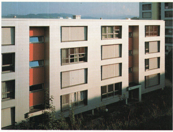
Die äussere Haut der neuen Eingangsfassade ist dort, wo früher das Betongeländer des offenen Balkons war – dafür werden die Wohnungen um gut 5 m 2 grösser
