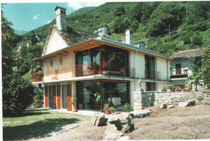
Das erweiterte Tessinerhaus im Dorfkern von Contra
