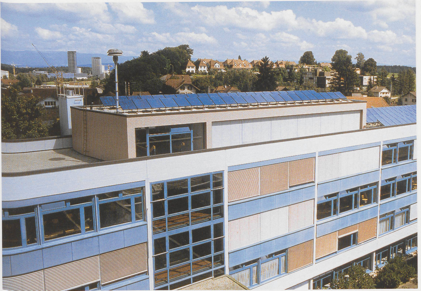
Oben die Photovoltaikanlage auf dem Schulhaus Gsteighof, unten die Anlage auf dem Dach der Ingenieurschule Tiergarten in Burgdorf
