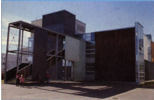
Schule Mustakivi Park, Helsinki Die vorgehängten Betonteile sind blau, grün oder braun lasiert und/oder mit der Patina des eingestreuten Kupfer- und Eisenstaubs überzogen. Die Vielfalt der Oberflächen zielt auf eine spielerische Atmosphäre und erfüllt so eine Anforderung des modernen schulpädagogischen Betriebs
