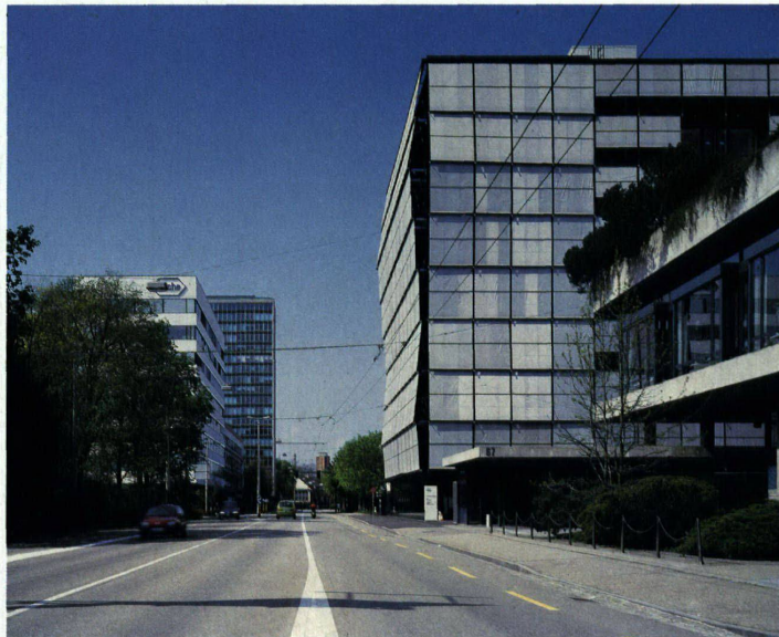
Das Gebäude steht direkt an der Trottoirkannte und tritt in der Grenzacherstrasse markant in Erscheinung. Die Sonnenstoren binden das zweigeschossige Foyer und im grossen Bogen die Bibliotheksgeschosse zusammen
