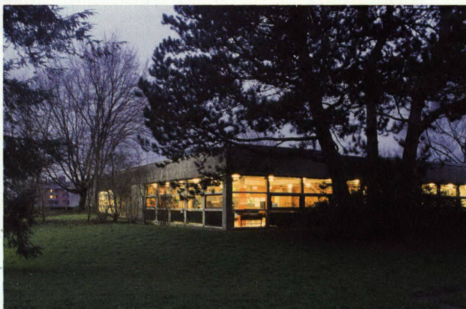
Jacques Schaders Betonpavillon aus den Sechzigerjahren gilt heute als schützenswert
