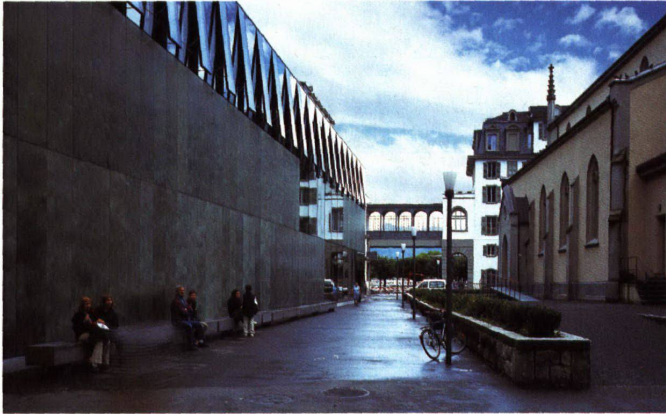
Zwischen dem Migros-Neubau und der Matthäuskirche verbinden halböffentliche Durchgänge die Hertensteinstrasse mit dem Schweizerhofquai
