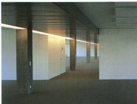
Das Tragwerk aus Ortsbeton benötigt nur eine Stützenreihe
