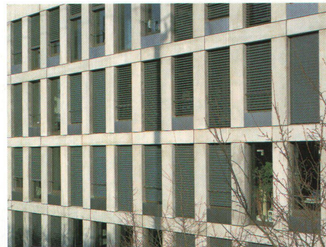
Der Glasanteil der Fassaden beträgt rund 50 Prozent
