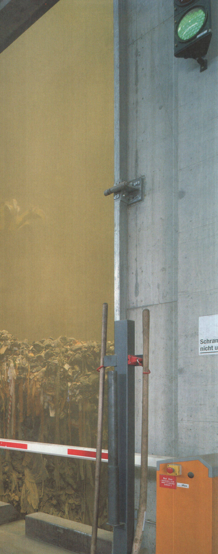
1 Das Tor zum Kehrichtbunker. Hier befindet sich der Geruchstiefpunkt des Nasenspaziergangs.
