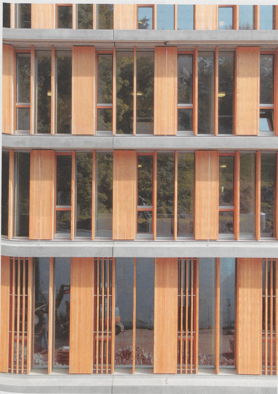
5 Blickwinkel in Richtung Südwest: Die Fassade verdichtet sich zu einem Holzraster, das Glas verschwindet hinter den Lamellen.
