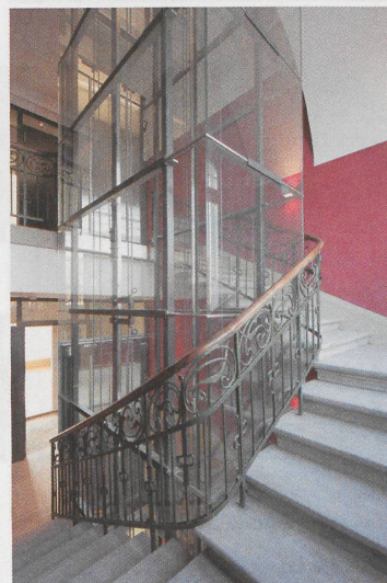
1 Im Auge der alten Treppe hat ein gläserner Lift exakt Platz gefunden. Fotos: Architekten
