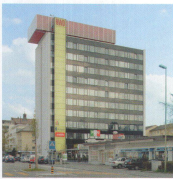
Fassade RWD Hochhaus, 2007 21
