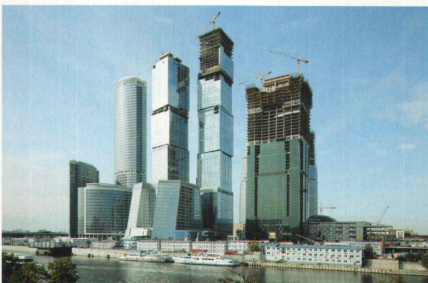
^ Moskau, 2008: Am Ufer der Moskwa wächst das Geschäftsviertel «Moscow City» in den Himmel. Zurzeit ist knapp die Hälfte der geplanten Hochhäuser im Bau oder bereits bezogen.
