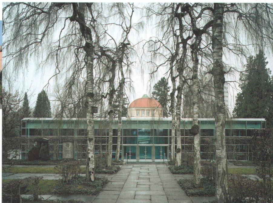
>22_Sanierung Abdankungshalle, 2008 Foto: Walter Mair
