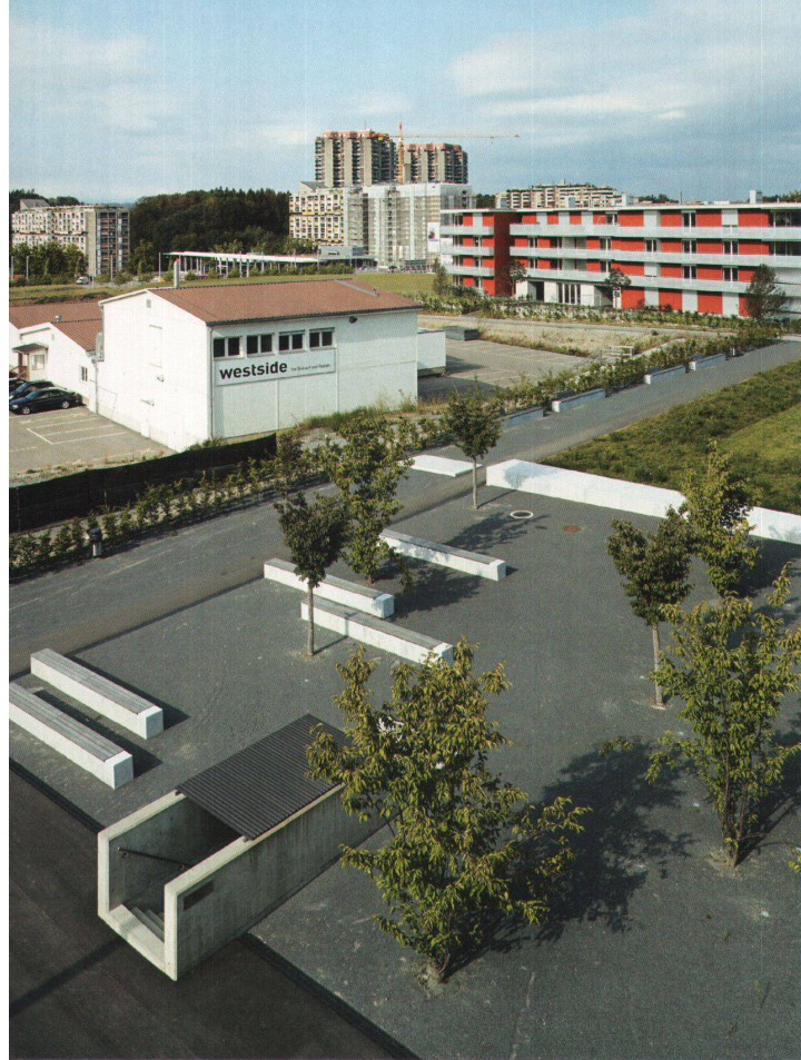
^1 Brünnen: Über der Autobahn liegt der Chaponnièrepark, nebenan liegt das Baufeld 7 noch brach. Die roten Häuser gehören zur Überbauung Come West.
