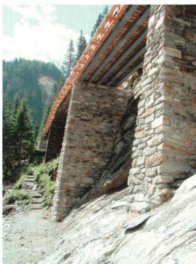
^Die rekonstruierte hölzerne Starlera-Brücke schloss eine Lücke der alten Averserstrasse.
