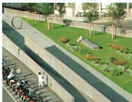
<Betonmauern grenzen den Park von der Umgebung ab, gleichen das Niveau aus und nehmen die Rampen und Treppen auf.
