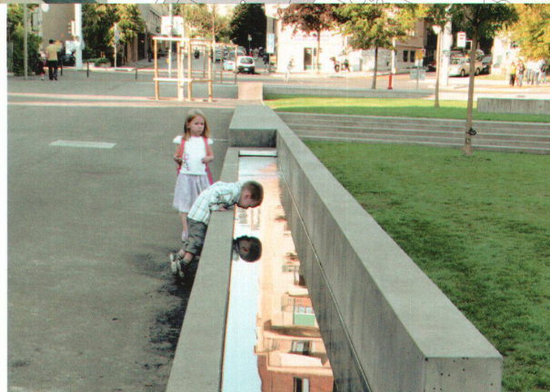
>Die Betonwand ist an einer Stelle auch ein Wasserbecken.
