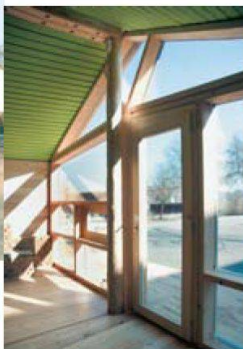
<33_Altes Handwerk: Pfosten und Balken sind ohne Leim verbunden.
